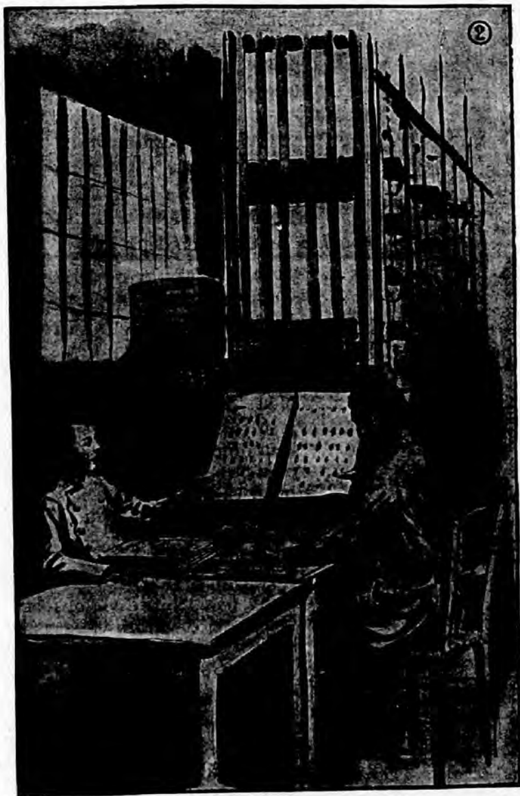
Machine à gommer et à sécher les timbres-poste.
