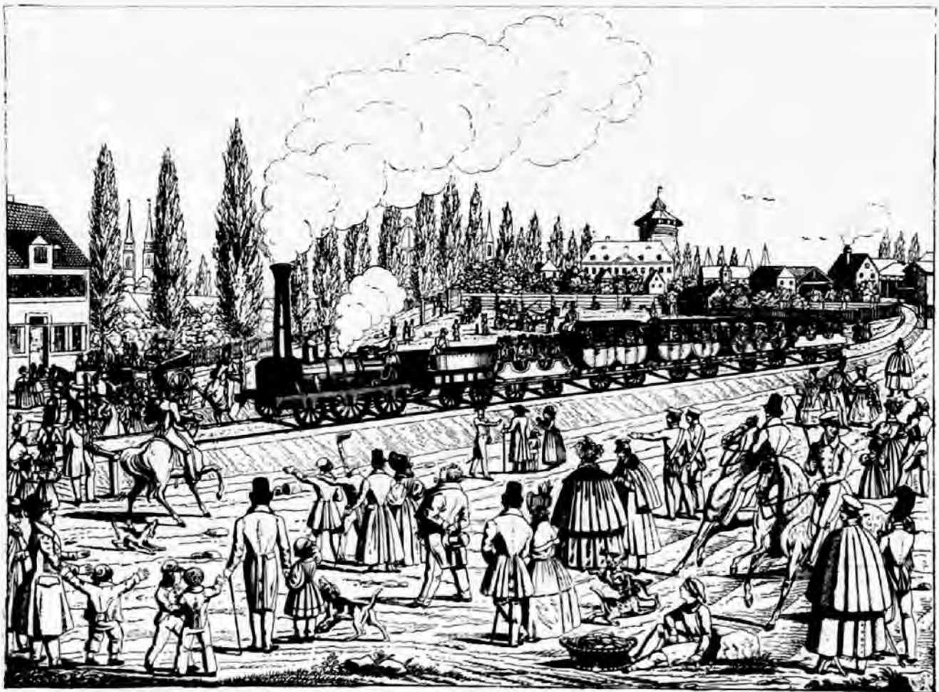
Eröffnung der Eisenbahn von Nürnberg nach Fürth am 7. Dezember 1835. (Nach der Aufnahme eines Augenzeugen.)
