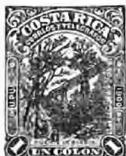
(Puente de Birris.) 35
